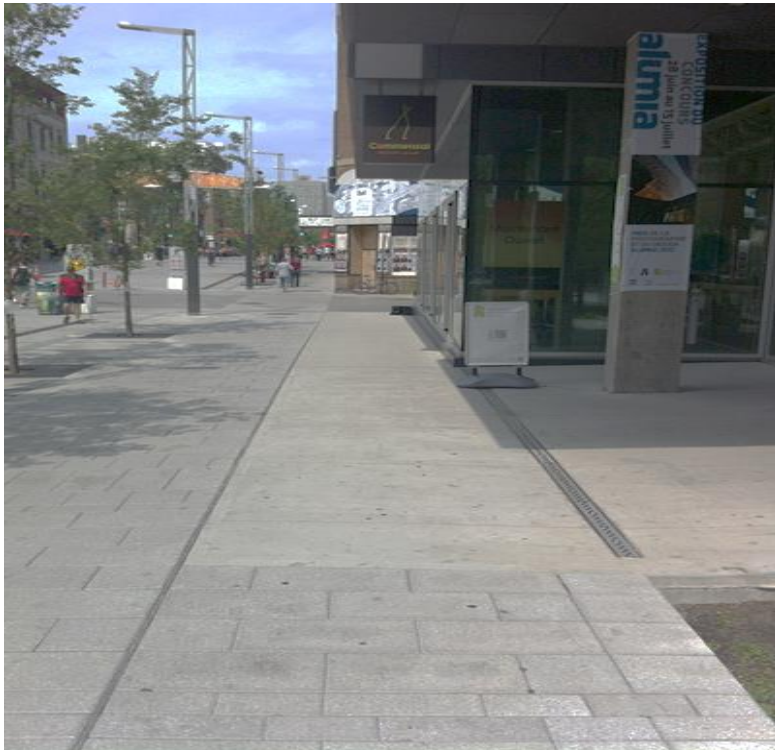
Maison du développement durable. Trottoirs et dalle intérieure (2010)
