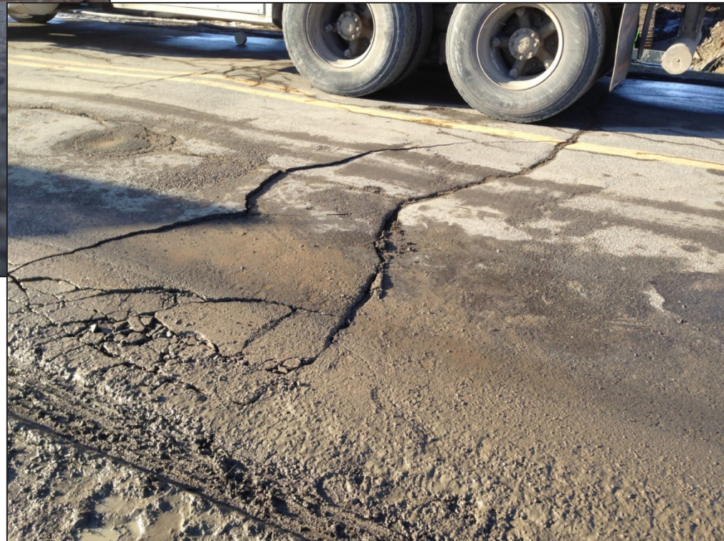
Source: NOEX Ingénierie sans tranchée
